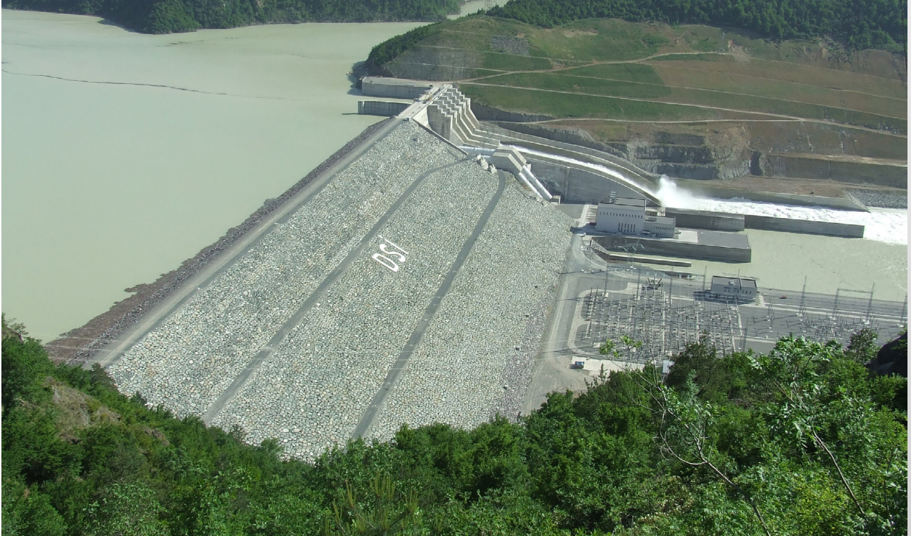
Borçka Barajı ve Hes Tesisleri / Artvin
